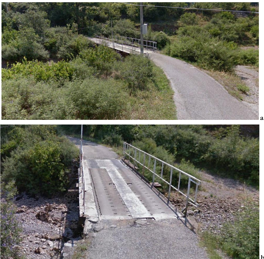
Slika 3 a i b. Izgled lokacije mosta
