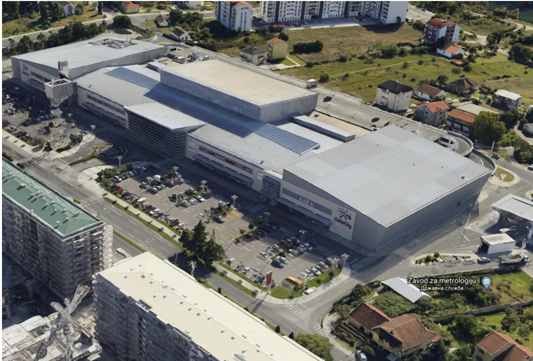
Slika 2.2. Izgled objekta na kojem se implementira projekat
