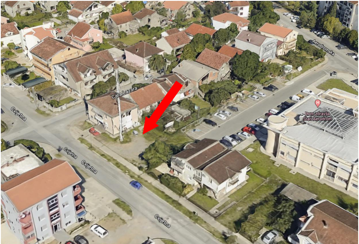
Slika 2.1. Lokacija bazne stanice
