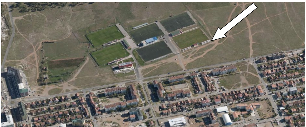
Slika 2.2. Uža lokacija bazne stanice sa prikazom njene pozicije
