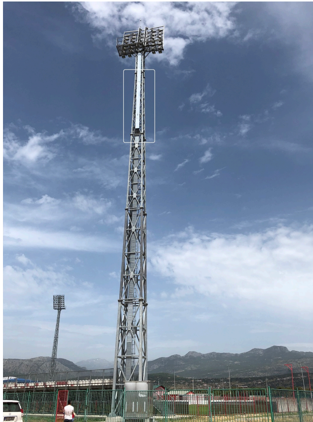
Slika 2.3. Izgled stuba na kojem se planira postavljanje antena
