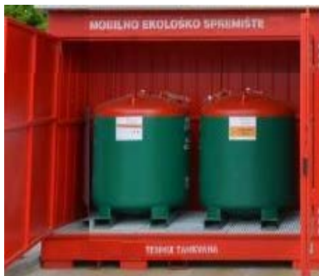
Slika 15. Izgled kontejnera sa posudama za skladištenje opasnog otpada
